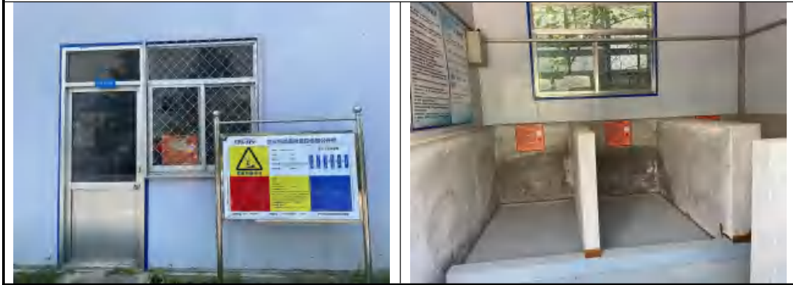
危废库现场照片
