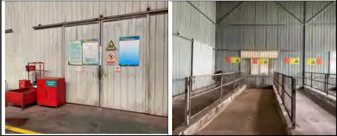
危废库现场照片
