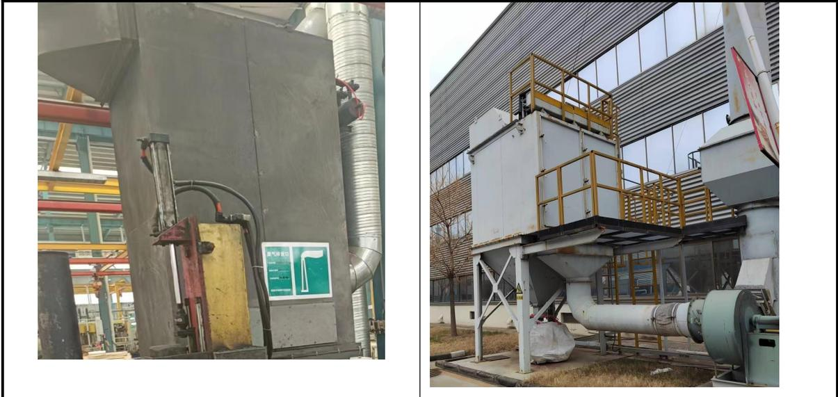
喷塑废气处理设施：室内滤芯粉尘收集系统
